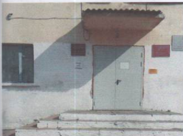
3. Входная площадка перед дверью
